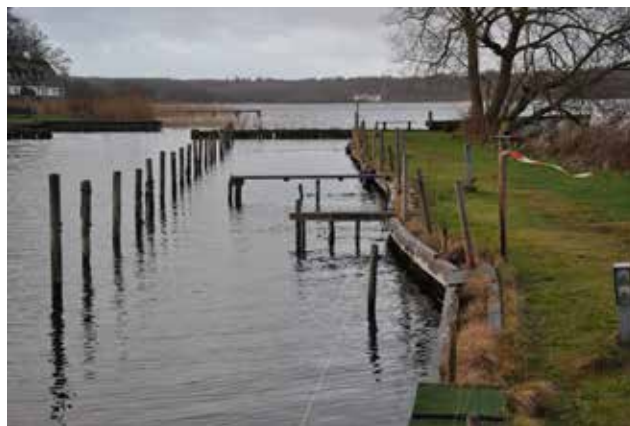
Molekanten fra 1976 havde efterhånden fået nogle udsving efter 27 år. Disse skulle udrettes, så der blot var et enkelt mindre knæk. Foto 30/12 2013.
