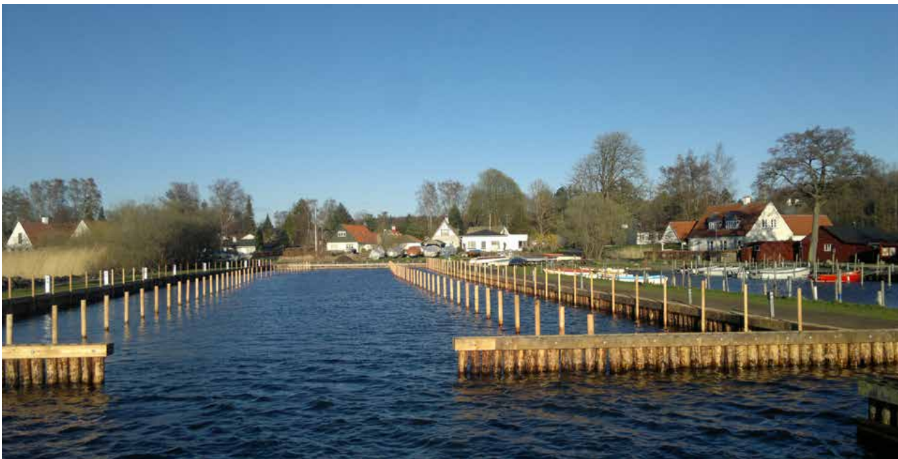
Arbejdet færdig i denne omgang. Kun molekanten fra midtermolen blev fornyet. El og armering blev udsat til senere. Foto 14/4 2014.
