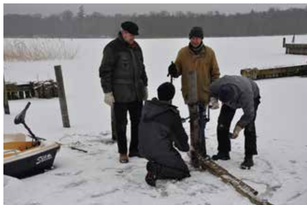
Bestyrelsens arbejde er alsidigt. Udskiftning af pæle må ske, når vejret muliggør det. Januar 2013.
