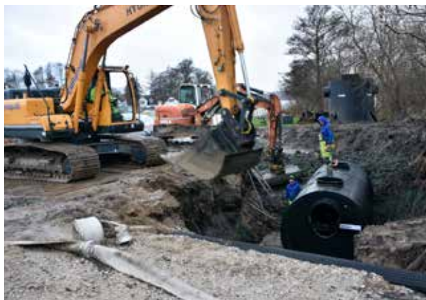
Sandfanget sænkes i det dybe hul. Foto 9/12 2019.
