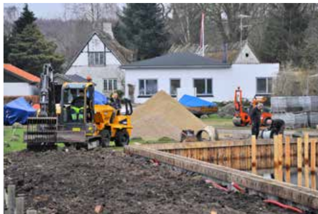
El-arbejdet er i gang og også midtermolen bliver forhøjet med nogle cm. jord og stabilt grus svarende til de andre steder. Foto 31/3 2017.
