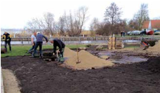
Rullegræs udlægges og der sættes af til fliseplads. Foto 2/4 2017.
