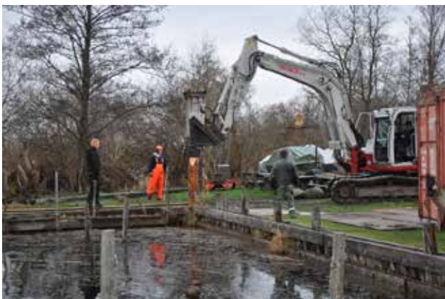
Først pæl bankes ned. Opgaven med pælenedramning var gået til Kystsikring ApS / Preben Winther Christensen – den sidste erhvervsfisker i Esrum Sø. Foto 7/1 2014.
