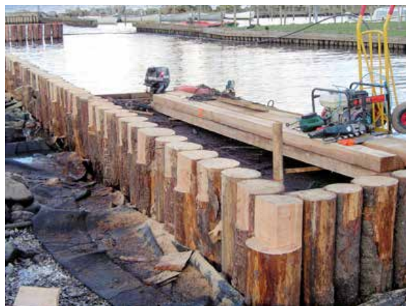
Lærkepælene er nu blevet skåret, så de foroven danner en vandret linje. Stammerne er blevet forankret med jernankre forsynet med lange jernrør mod landside for at sikre at de over tid forbliver i samme position. På fotoet ses en jernstang under den sorte dug. I toppen forstærkes med høvlede lærketvinger på såvel inder- som yderside. Forinden er det dog nødvendigt at foretage tilpasninger af pælene. Foto 4/3 2008.
