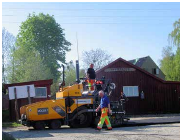
Sidste arbejde var asfaltering af vejen, som betød at vejniveauet blev hævet lidt af hensyn til afledning af vandet. Der blev kun nyasfalteret ud for havnens område, men naboerne var blevet inviteret til at deltage på deres vejstykker. Foto 8/5 2008.
