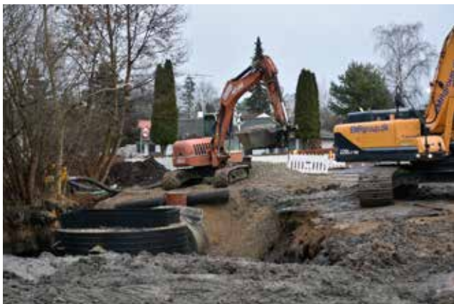
Oliefilteret sat på plads. Foto 12/12 2019.
