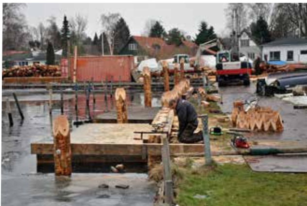
Træfpunktet øverst på pælen saves af, og pælene tilpasses, så tvingerne får kontakt til alle pælene. Foto 4/2 2014.
