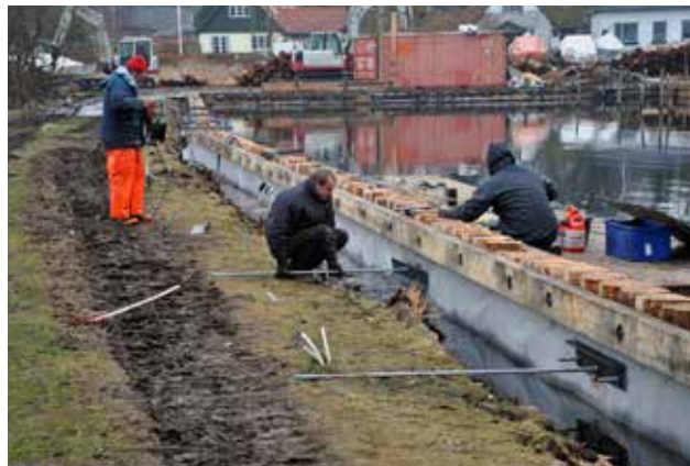
Pælene forankres til det omkringliggende areal. Foto 11/2 2014.
