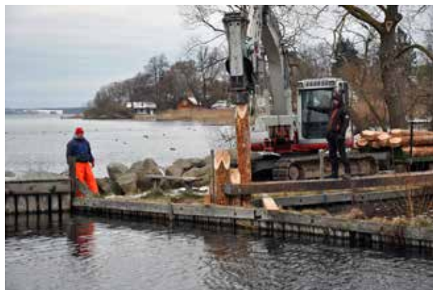
Nedramningen skulle helst ske lodret. Derfor var der konstant 2 mand, der gav tegn til vognføreren. Foto 22/1 2015.
