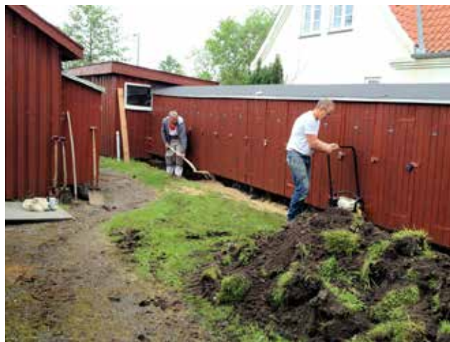
Større arbejder som nedlægning af græsarmeringssten bliver også udført på arbejdsdagen.
