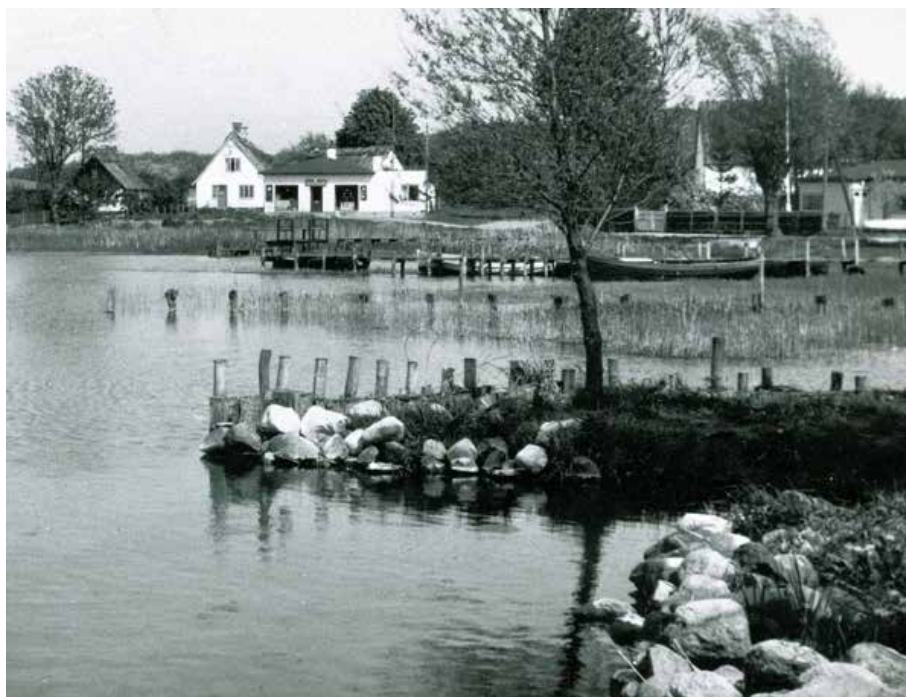
Sørup Havn fra slutningen af 1940'erne. I forgrunden ses indsejlingshavnen til erhvervsfiskeren. I baggrunden anes havnen for småbåde, som bestod af simple bådebroer. Længs Sørupvej ses nuværende ejendomme 39 og 43 og tidligere nr. 41. I Sørupvej 43 var der foruden bolig også købmandsforretning. Bemærk at søen gik helt ind til Sørupvej. Der ses også begyndende sivskov. Fredensborg Arkiverne.
