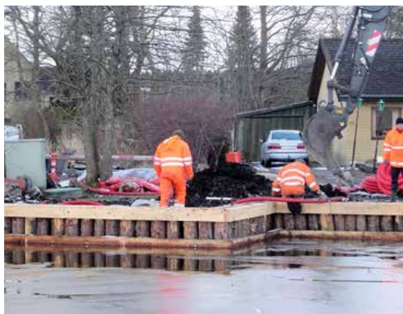
Nu er tvingerne kommet på plads også på ydersiden og yderligere til forstærkning er der påsat tvinger i vandkanten. De nederste tvinger er sat således, at undersiden svarer til flodemålet 0 cm. Der arbejdes med rør og ledninger til de el-standere, der skal opsættes således, at hver stander kan levere strøm til 4 bådpladser. Foto 25/3 2008.
