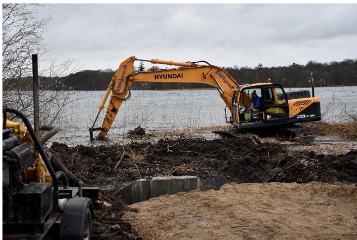
Klargøring af det yderste rørudløb i Esrum Sø. Foto fra 15/1 2020
